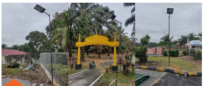
Program Sumbangan Lampu Solar di Sg Tengi Selatan.
